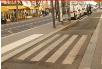
バス停の歩道側にある分離一通方式 (歩行者が横断する部分は高くしている、バス停の向こうは駐車帯)
